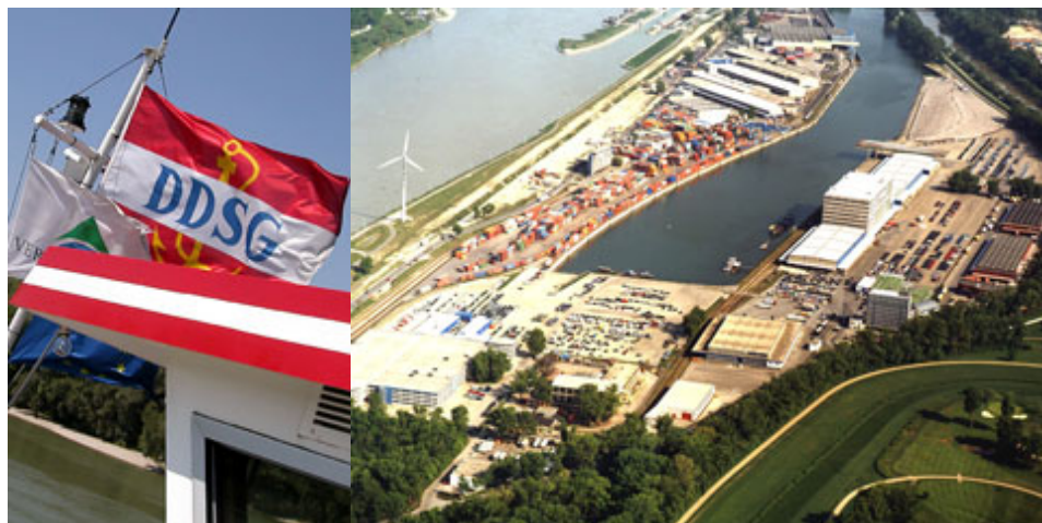
Nowy terminal kontenerowy Wien - Freudenu (po prawej)
